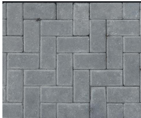
Figura 03: paginação de blocos intertravados da calçada.
