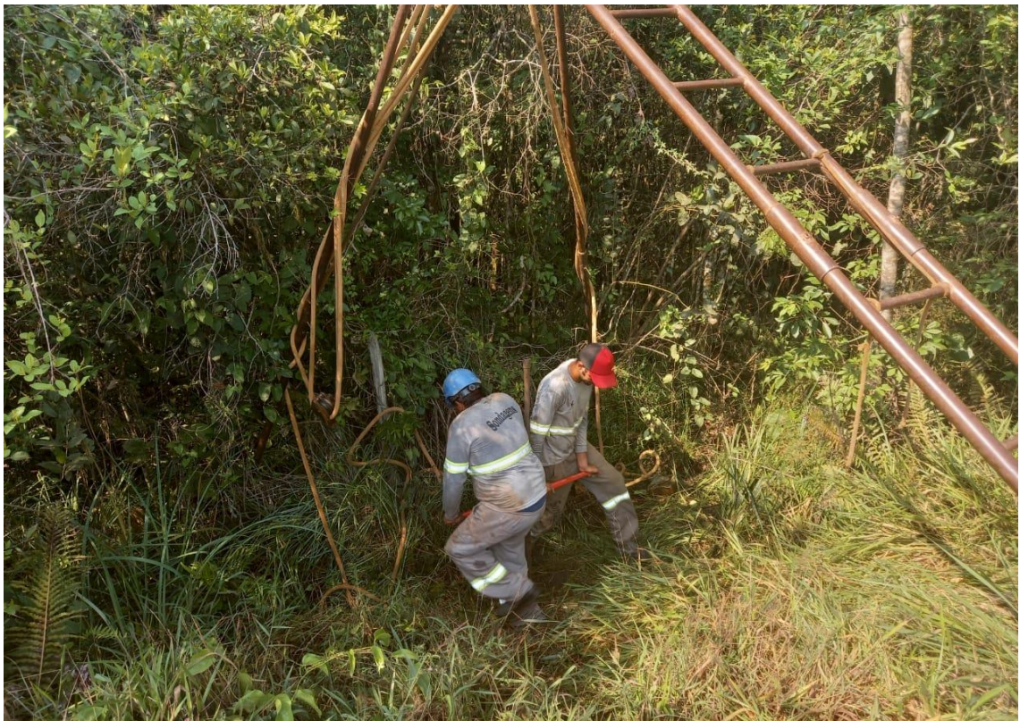
FOTO 2 - AVANÇO DA PERFURAÇÃO DO SOLO COM TRADO
