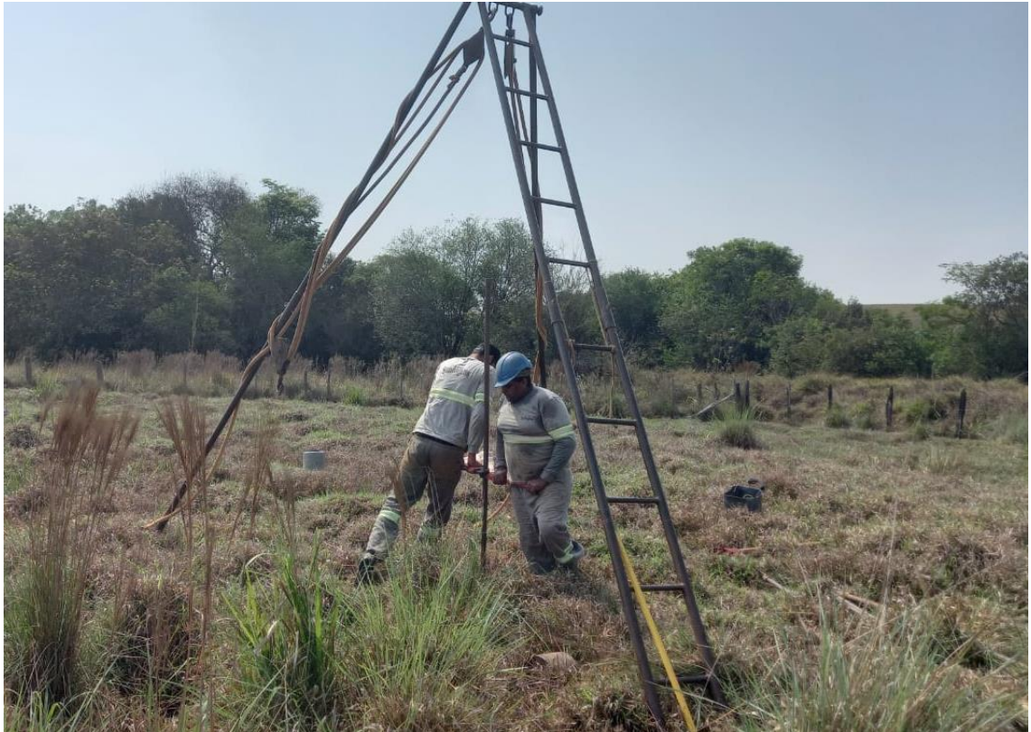
FOTO 1 - AVANÇO DA PERFURAÇÃO DO SOLO COM TRADO
