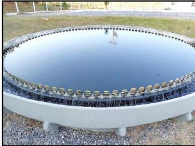
Figura 69 - Decantador secundário em condições adequadas de operação em 2016.
