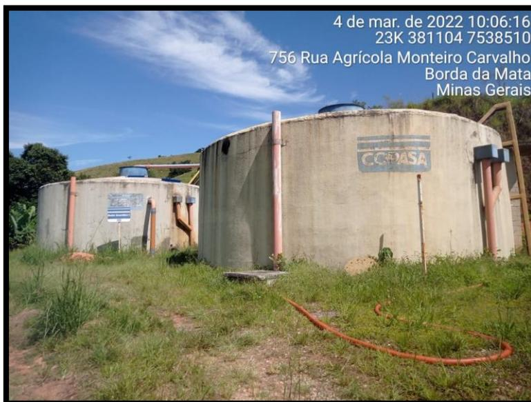
*Figura 65 - Reatores UASB da ETE.
