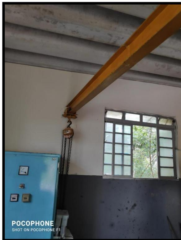
*Figura 26 - Guincho Talha e Coluna para eventuais retiradas dos conjuntos motobomba.
