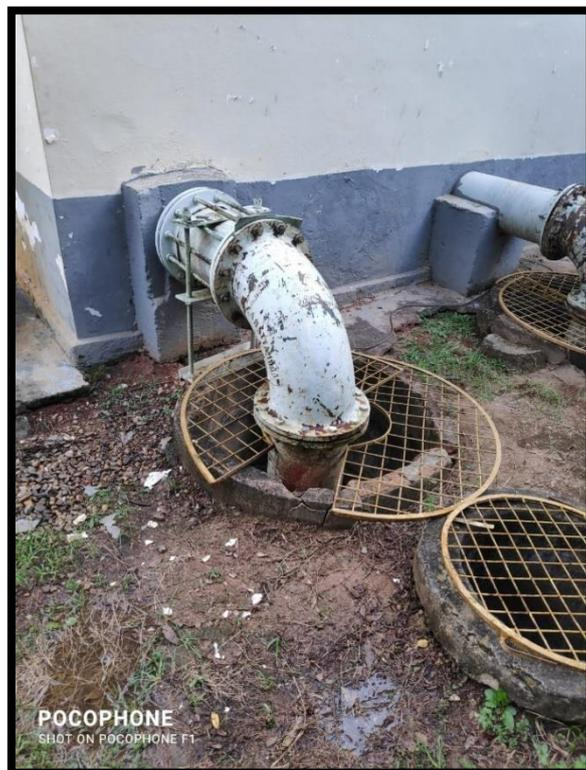
Figura 24 - Tubulação de sucção da Estação Elevatória de Água Bruta – EEAB.
