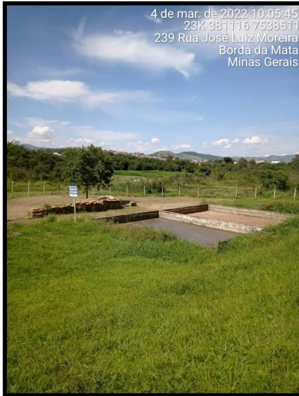
Figura 71 - Leitos de Secagem para o lodo da ETE.
