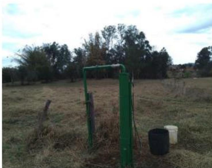
*Figura 55 - Poço tubular profundo da Serrinha.
