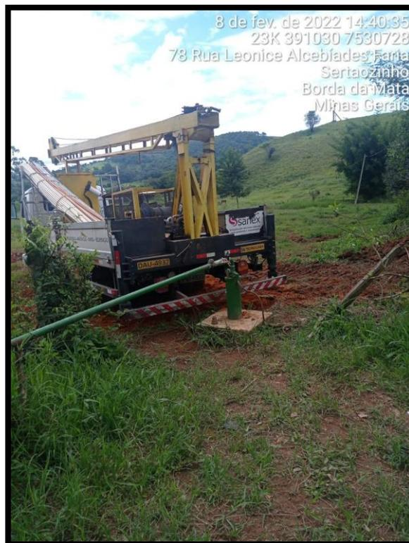
Figura 47 - Poço tubular profundo no Distrito do Sertãozinho em manutenção.
