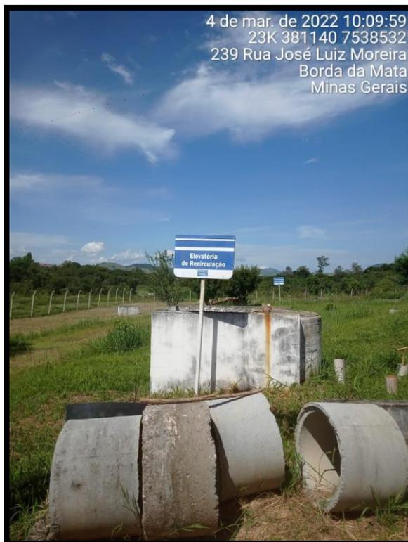
Figura 72 - Estação Elevatória de Recirculação do lodo da ETE e aduelas de concreto soltas.
