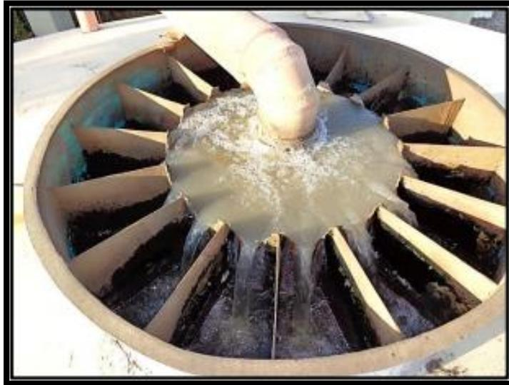
Figura 67 - Distribuição uniforme do efluente nos vertedores do Reator UASB em 2016.
