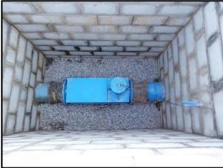
Figura 73 - Caixa para abrigo do sensor de medição de vazão em 2016.
