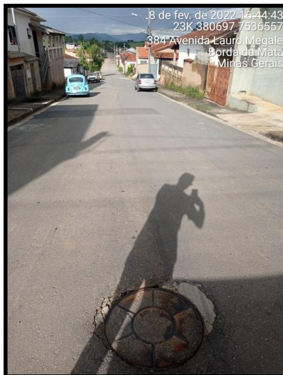
*Figura 88 - Tampa de Poço de Visita do Sistema de Galerias de Águas Pluviais de Borda da Mata.
