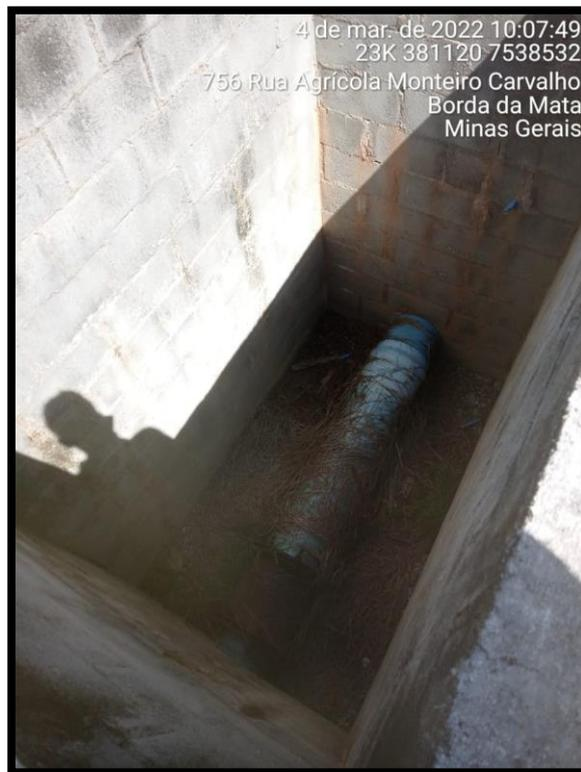
Figura 74 - Caixa para abrigo do sensor de medição de vazão em mau estado de conservação.
